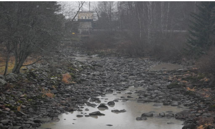
Kuva 6. Näkymä riippusillalta Askalan padolle päin.
