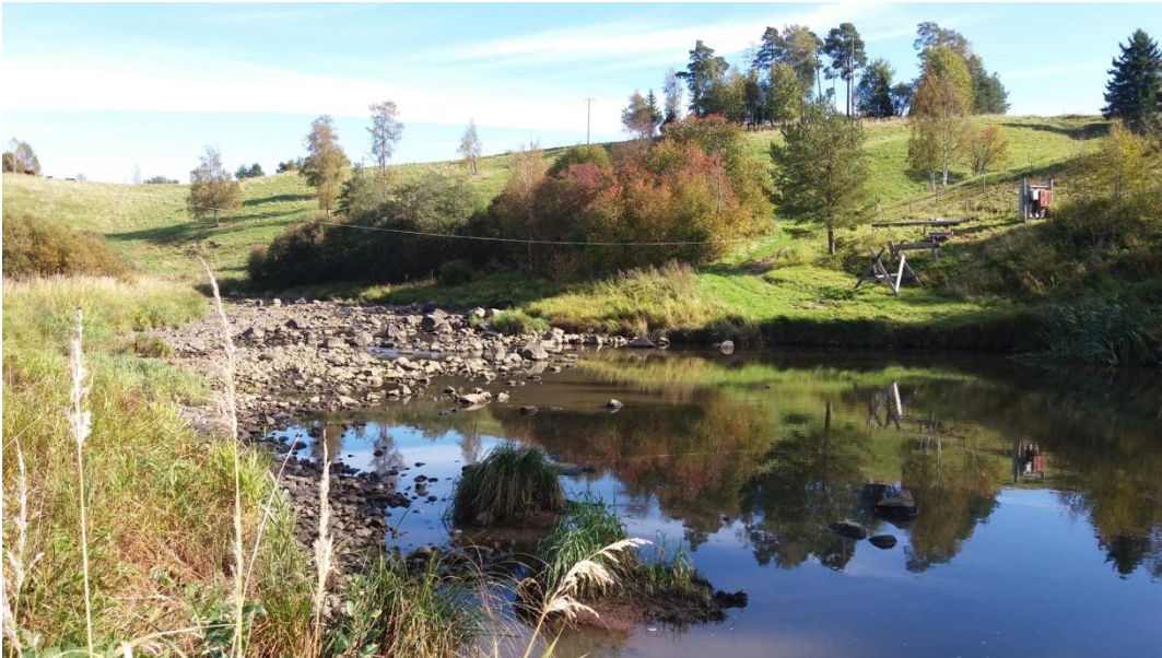
Kuva 1. Kajanojankoski ennen patoluukkujen avaamista.
